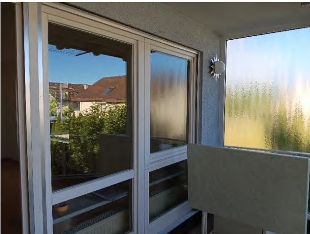
Seitlicher Windschutz am Balkon
