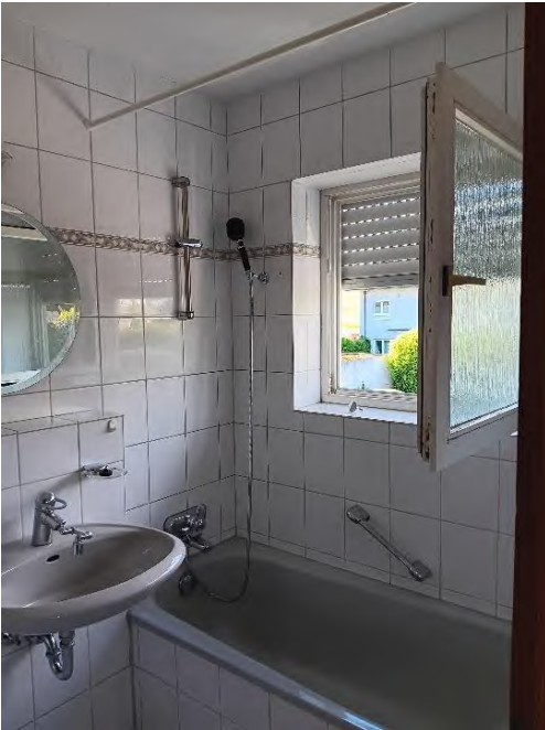
Außenfenster im Bad
