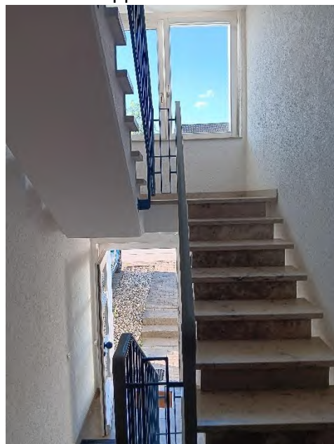
Weitere Treppe zum 1. OG
