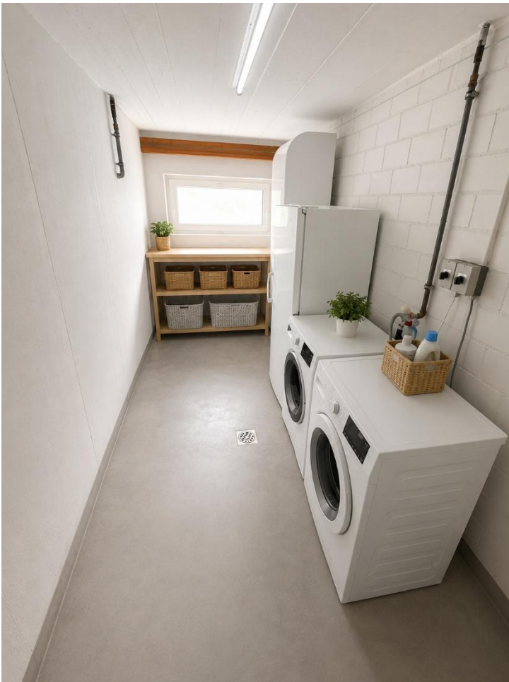
Eigene Waschraum im UG
