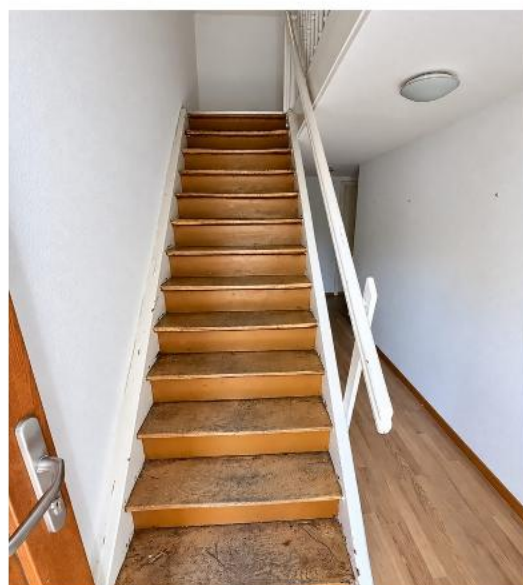
Treppe ins Obergeschoss
