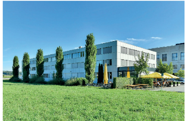
Südwest-/Südostfassade, Gartensitzplatz Restaurant
